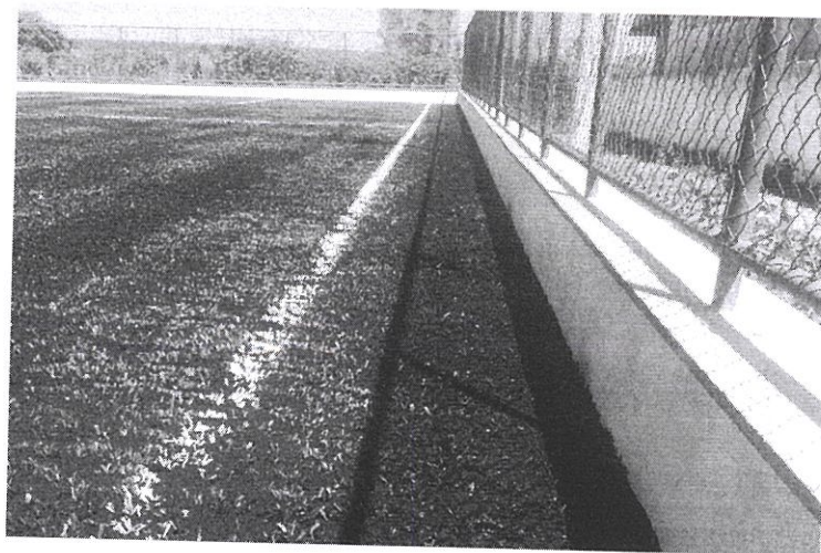
FIGURA 03 – MURETA E ALAMBRADOS CONCLUÍDOS
