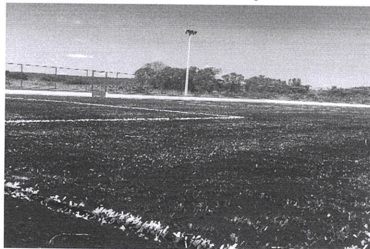
FIGURA 02 – ALAMBRADOS E TRAVES CONCLUÍDOS
