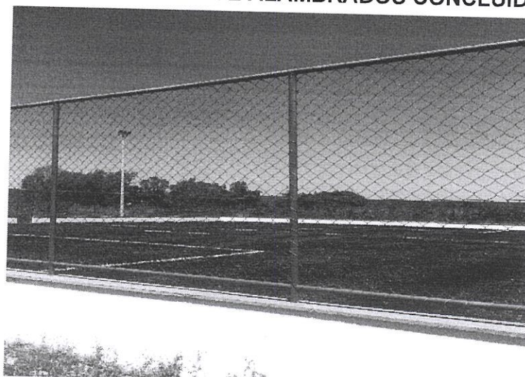
FIGURA 04 – VISTA GERAL ARENINHA CONCLUÍDA.
