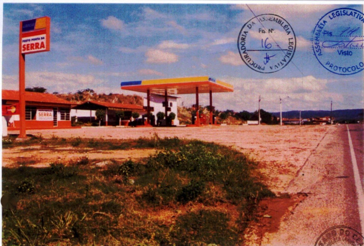
07 - POSTO DE COMBUSTÍVEL PONTA DA SERRA
